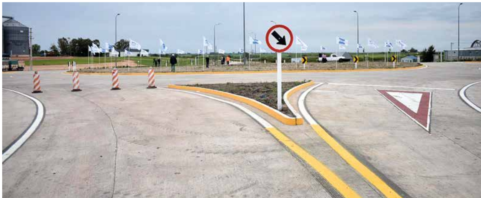
UN ACONTECIMIENTO: PRIMERA OBRA VIAL POR PPP
