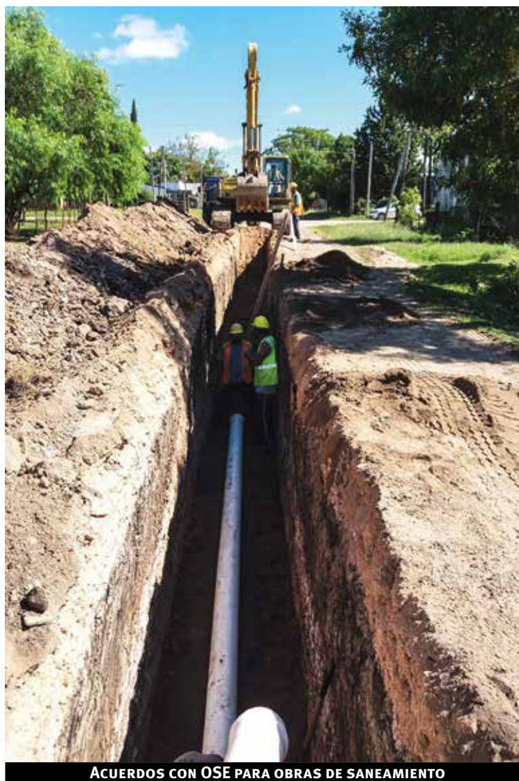
ACUERDOS CON OSE PARA OBRAS DE SANEAMIENTO
